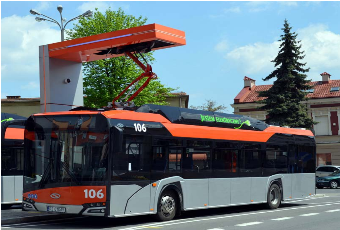
Stacja ładowania autobusów elektrycznych (przy dworcu PKP)
